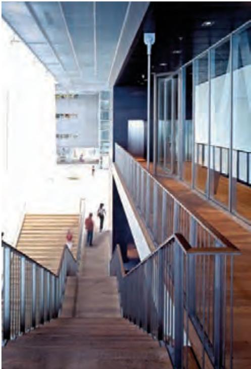
**Figg. D.1.1.16-17** - Il cemento a vista delle pareti, i cavi d'acciaio che sostengono piani e rampe sospese, e il legno impiegato per i pavimenti e le scalinate determinano l'immagine formale interna dell'edificio.
