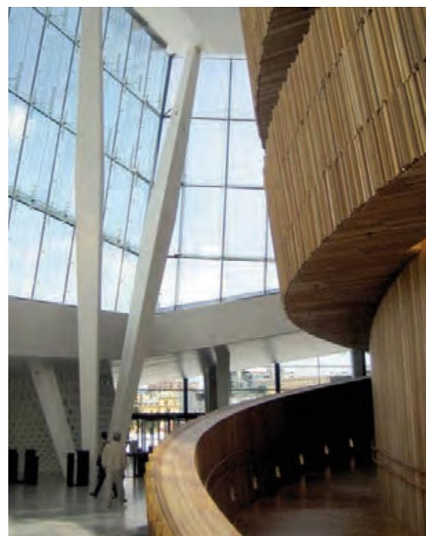
**Figg. D.2.8.12-13** - Il foyer è caratterizzato dal vivace contrasto tra i materiali "glaciali", che si insinuano dall'esterno, e il legno fasciante, che modella la forma della sala e della rampa che attribuisce gli accessi alle balconate.
