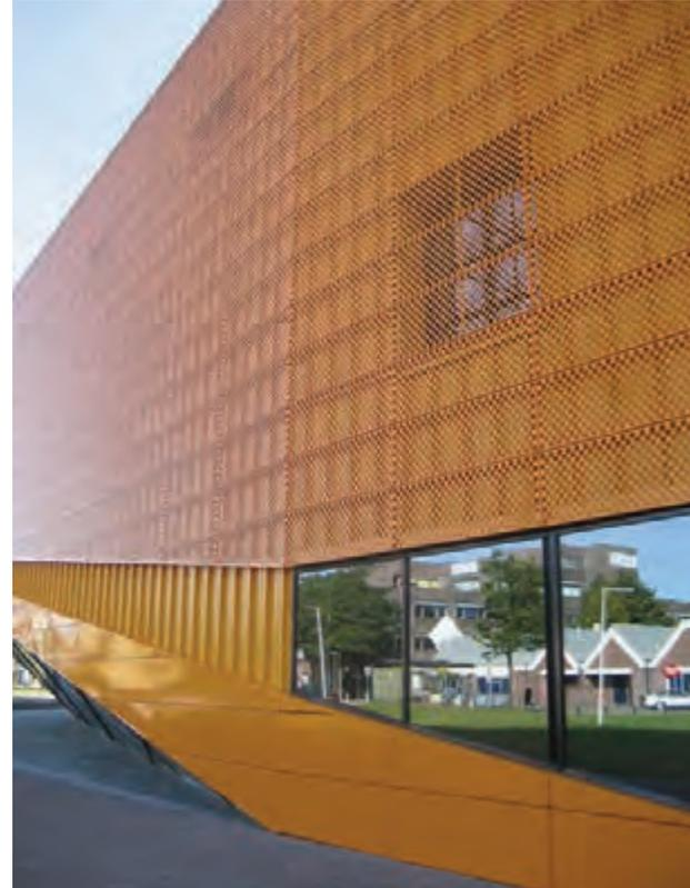
Fig. D.1.3.9 - Lastre traforate e opache si sovrappongono per creare differenti effetti cromatici.
