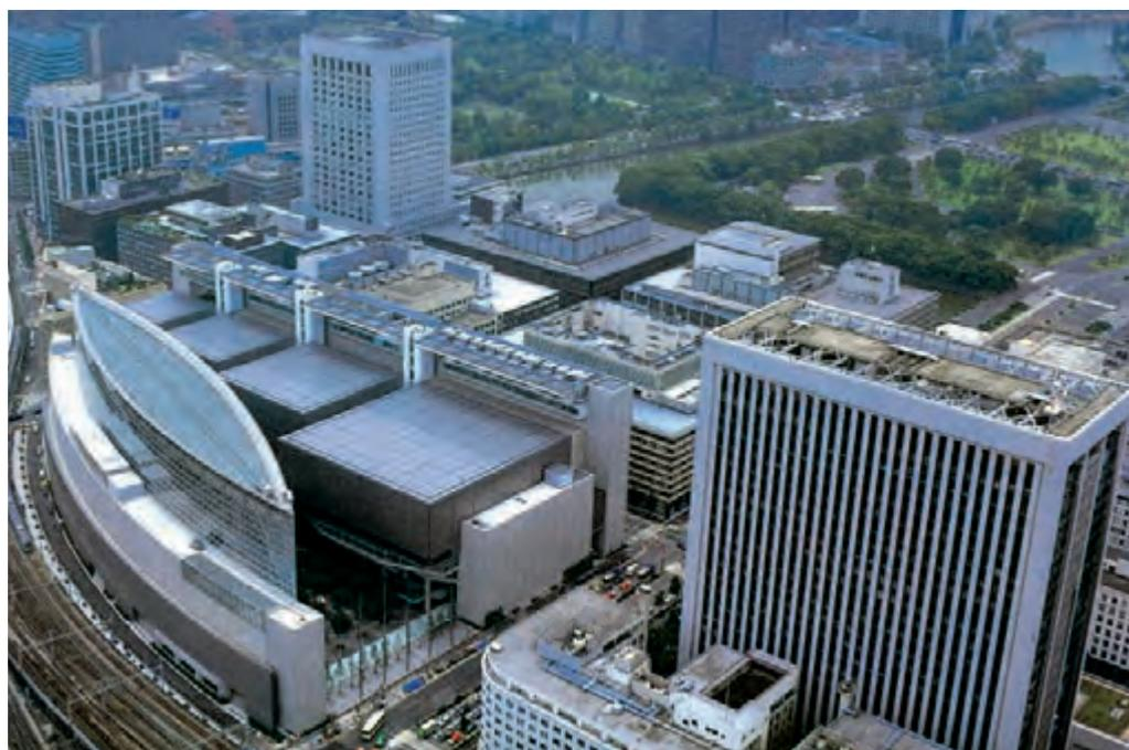
Figg. D.3.2.3-5 - La scelta più caratterizzante è rappresentata dal volume a pianta lenticolare che ospita, al piano della strada, l'ingresso principale. Esso, sul versante della ferrovia, segue la curva del lotto costituendo una barriera molto efficace al rumore dei treni.
